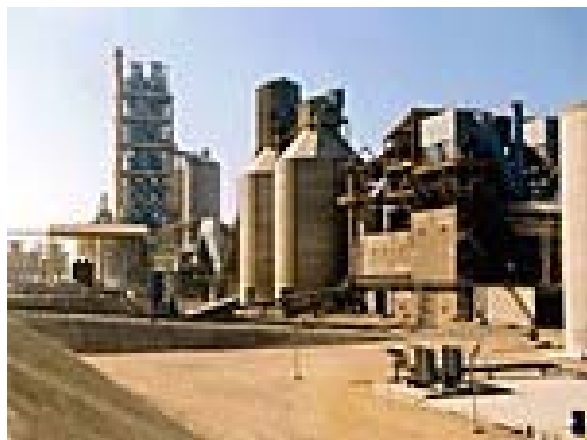
Nhà máy xi măng
